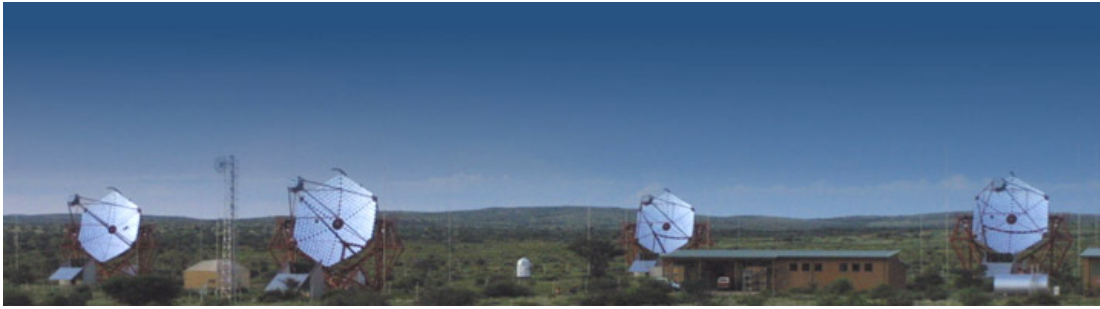
ABBILDUNG 2.5: Das H.E.S.S.-Teleskopsystem. Die Teleskope von links nach rechts: erstes (CT03), drittes (CT04), zweites (CT02) und viertes (CT01) H.E.S.S.-Teleskop. Rechts der Bildmitte befindet sich das Kontrollgebäude. Der Mast in der linken Bildhälfte trägt eine Mikrowellensende- und -empfangsanlage zur Abwicklung der Telefon- und Internetkommunikation. Ganz rechts ist der Dieseltank und ein Teil des Generatorgebäudes zu sehen. In der Bildmitte befindet sich zudem ein optisches Teleskop der ROTSE-Kollaboration zur Untersuchung von Objekten mit vorübergehenden Phasen hoher Aktivität. [Photo: H.E.S.S.-Kollaboration]
